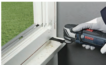
④窓枠取り外し
