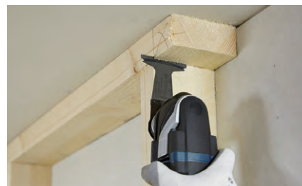
⑥外枠調整面一切断
