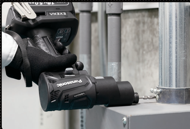
電線管の固定
