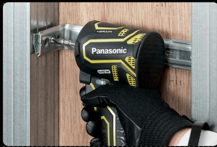
ボックス支持金具の取り付け
