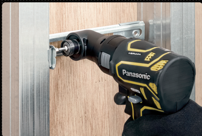
配線支持金具取り付け
