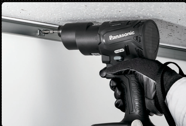
壁際のメタルモールの取り付け
