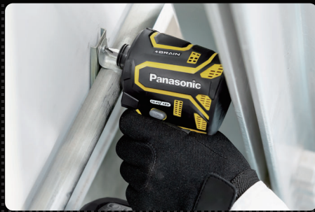
配管固定サドルの取り付け
