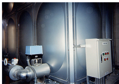
モリマツ緊急遮断弁システム付タンク(オプション)
