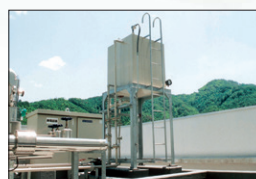
オイルサービスタンク P16 Oil Service Tanks
