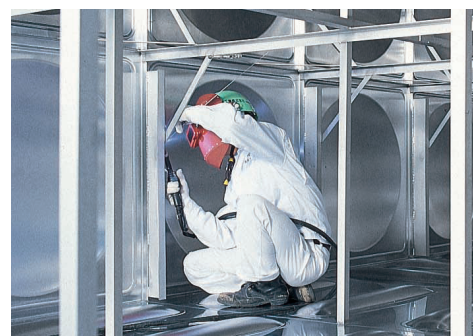
パネルタンクは全溶接構造
