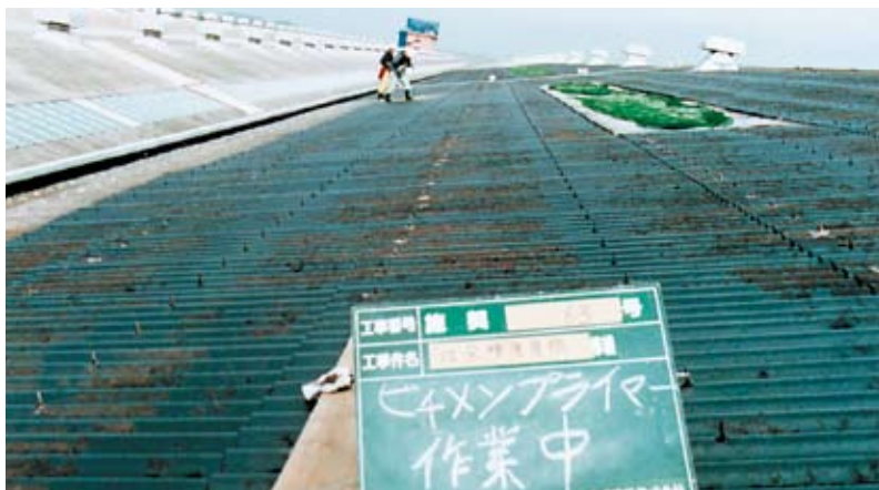
プライマー塗装
