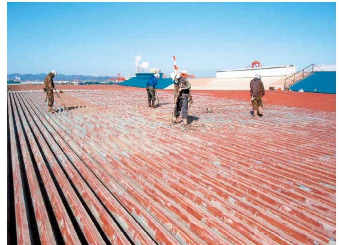
電動サンダーによる下地ケレン作業
