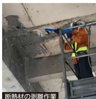
断熱材の剥離作業
